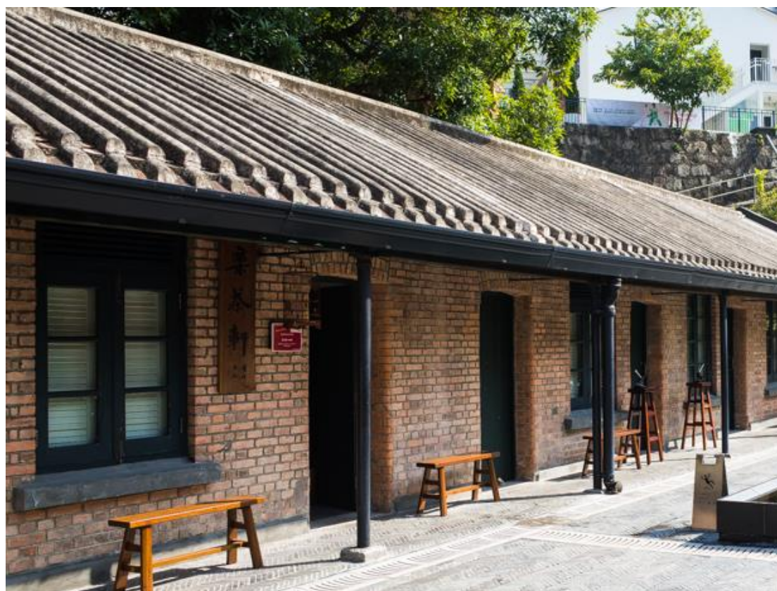
磚屋門外被磨成圓角，方便病床進出室內外（照片來源：饒宗頤文化館）
