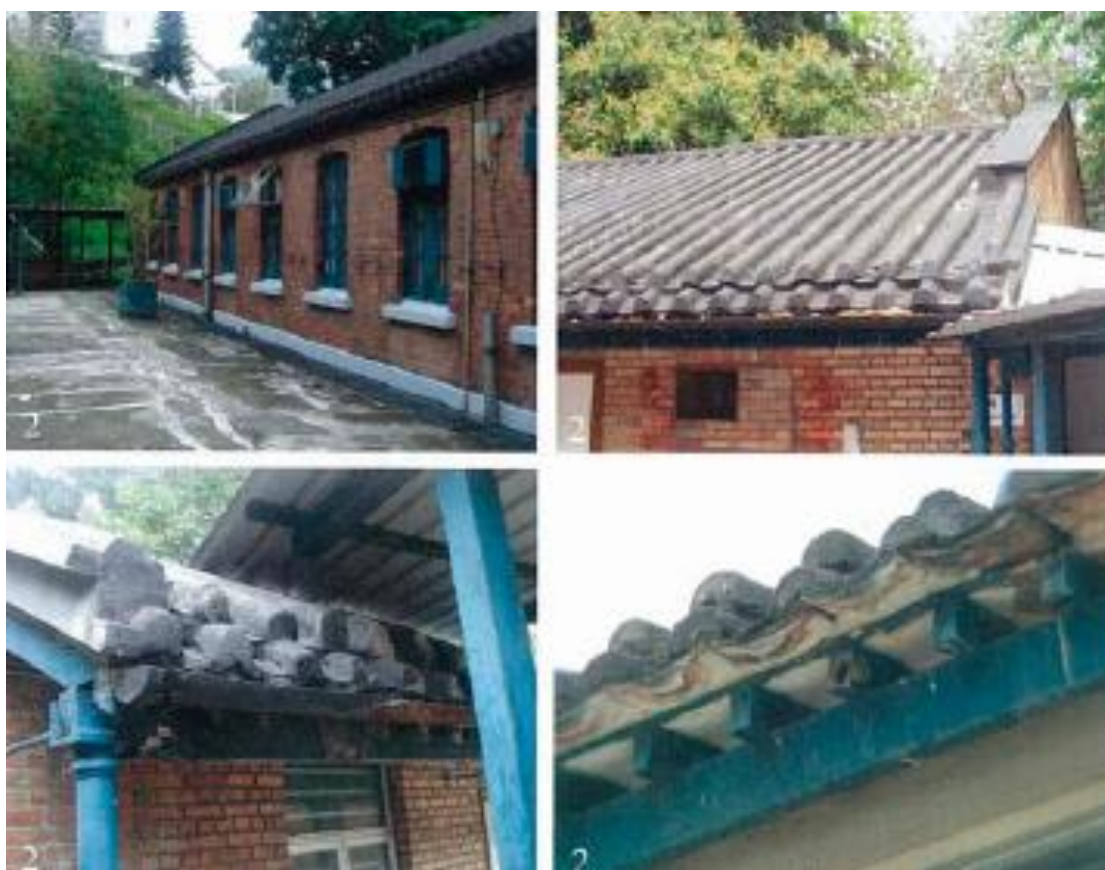
英式紅磚建築風格，加上中式雙層瓦頂及木製桁架結構 (資料來源：中創顧問有限公司；2009)
