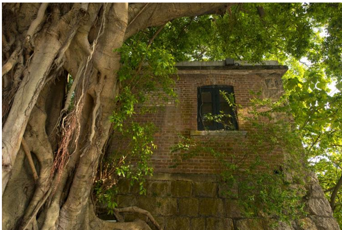
舊警衛室 (向停車場)
