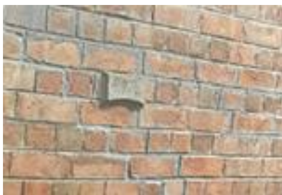
下區多個位置的裂痕探測器（照片來源：饒宗頤文化館）
