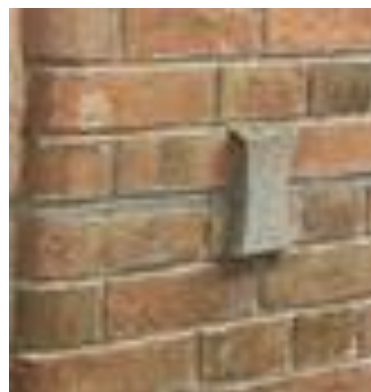
下區多個位置的裂痕探測器（照片來源：饒宗頤文化館）
